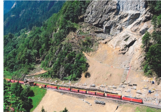
Am Morgen des 5. Juni 2012 stürzten etwa 3000 Kubikmeter Gestein auf die Nordrampe der Gotthardlinie.
